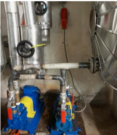
Abbildung 1: Kondensatpumpen
