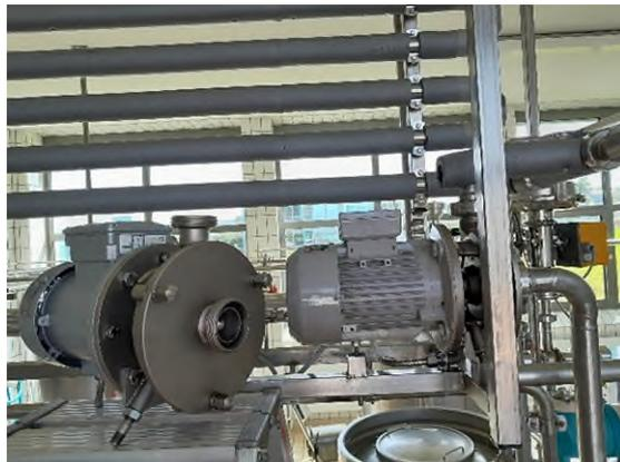
*Abbildung 3: Druckerhöhungspumpe*
