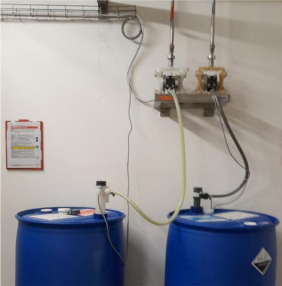
Abbildung 4: Pneumatische Membranpumpen
