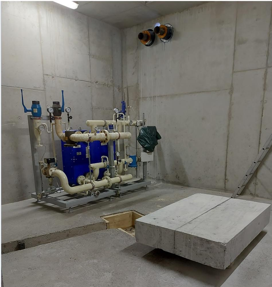
Bild: Fernwärmeanschluss-Station in Heizzentrale MVB
